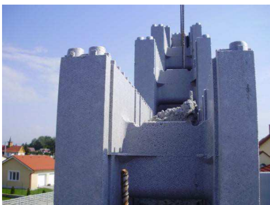
Betonstahlbewehrung in den Reihen
