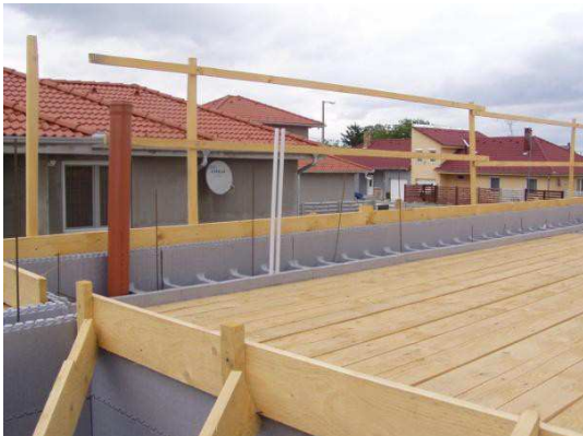
Befestigung der Kronensteine von der Außenseite
