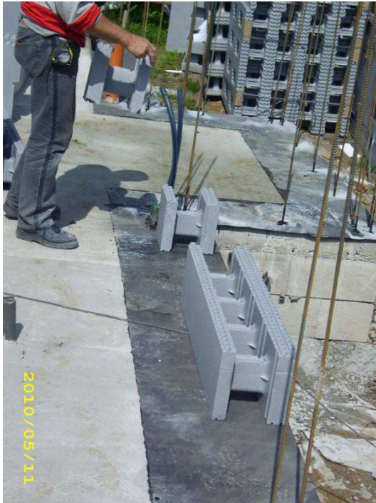
Isolierung unter der ersten Wandreihe
