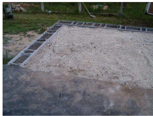
Füllung der Bodenplatte mit Kies
