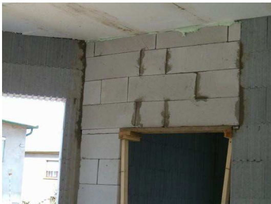
Einbau, Überbau von Innenwand
