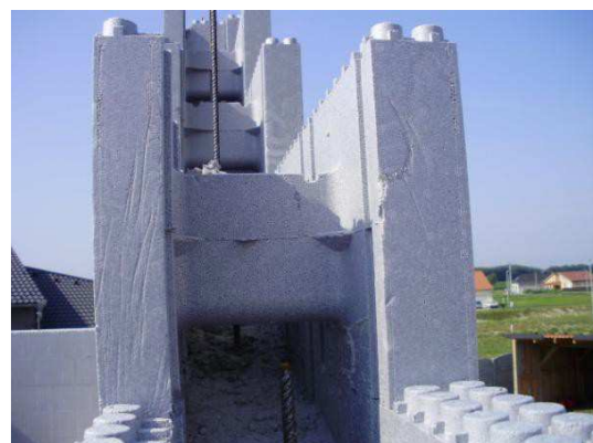
Betonstahlbewehrung in den Reihen
