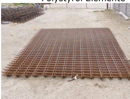
Lastverteilende Stahlkörbe
