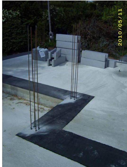
Isolierung unter der ersten Wandreihe
