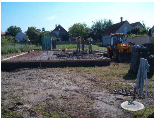
Füllung der Bodenplatte mit Beton
